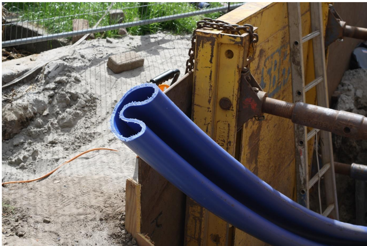
Afbeelding 3. Toepassing compact pipe in Zwaagwesteinde, Friesland, als onderdeel van het TKI-project 'Slim renoveren van waterleidingen'
